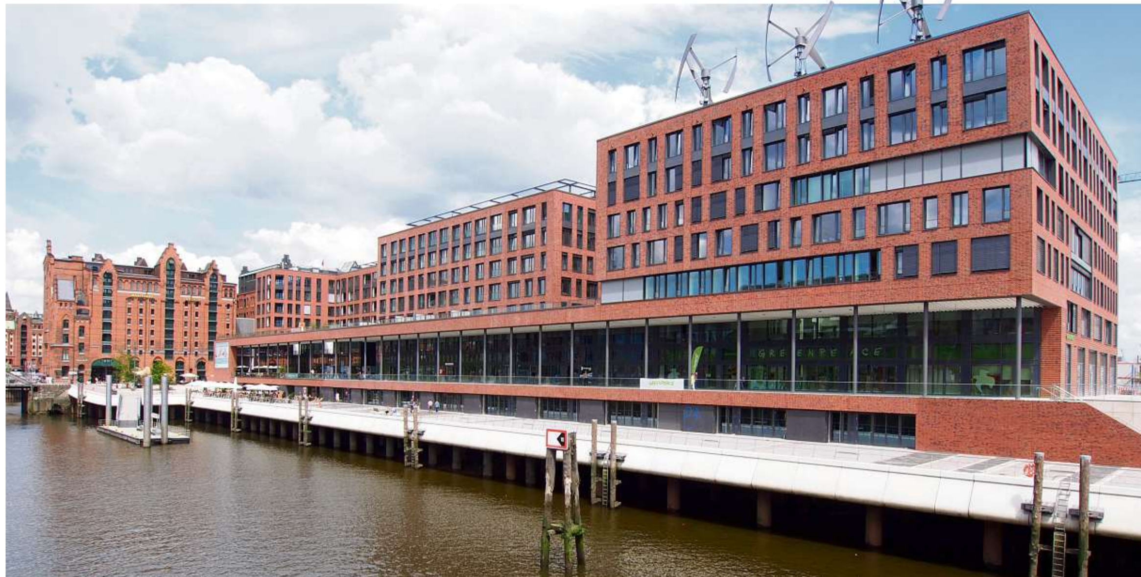
Die Elbarkaden mit dem Designxport in den drei unteren Etagen von der Wasserseite aus gesehen: Erst 2014 wurde die Ausstellungsfläche eröffnet. Nun ist sie für mehrere Monate geschlossen
